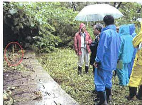
山腹沿いに位置しており、固結した火山灰系の土質が凍結融解の繰り返しによって山腹崩壊を起こし、それに伴って樹木のある表層部分の滑落が起きているが、水路壁からのステップがある程度あつたためか、現況は安定勾配状態となっている。
