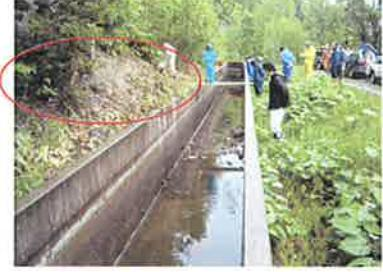
国営事業でフトン籠を設置した部分はある程度ステップが有るため、多少は崩落土がオーバーランしているが支障は無いように伺えるが、ステップが殆どなく崩落土がオーバーランをして、水路本体に土砂堆積の状況を造り出している部分がある。
