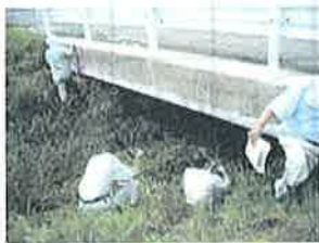
No.1 : 南富士見橋
