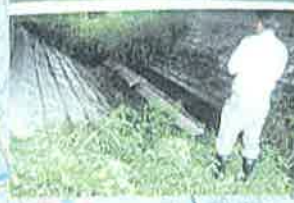
No. 1 : 南富士見橋
