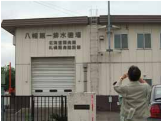
11 八幡第一排水機場全景
