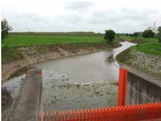
13 取水口上流部
