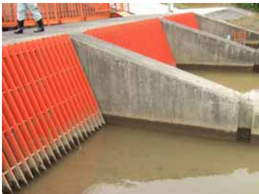
7 取水口上流から
