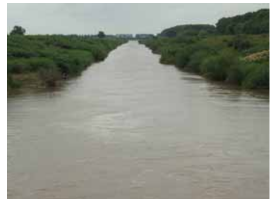
24 水位上昇施設(堰上げ) 下流
