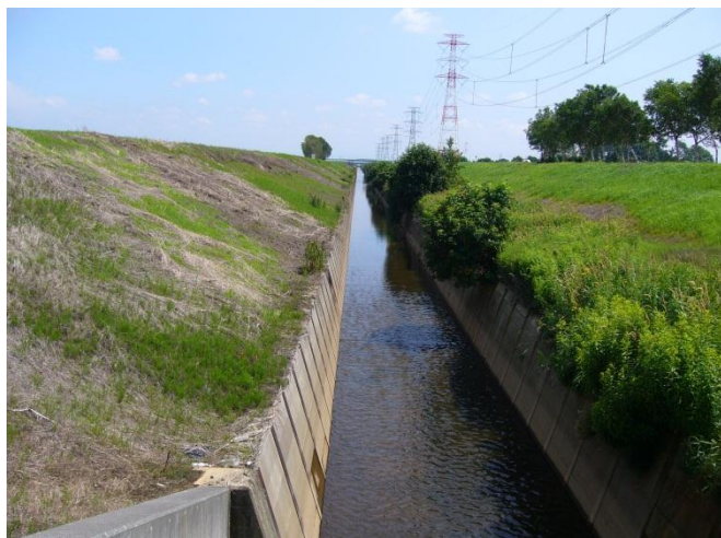
両サイドの柵渠工共、異常なし。土砂堆積、水草繁茂もなし。
