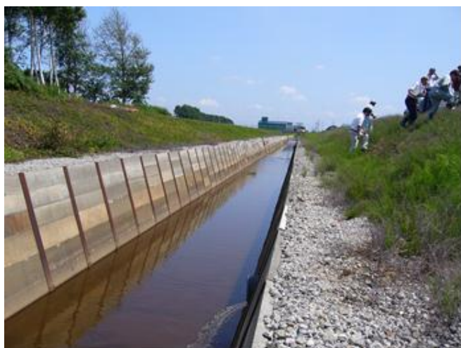
両サイドの柵渠工共、異常なし。土砂堆積、水草繁茂もなし。
