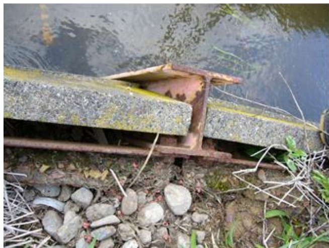
裏込砂利の欠損によるコンクリート柵渠板のガタツキ状況。
