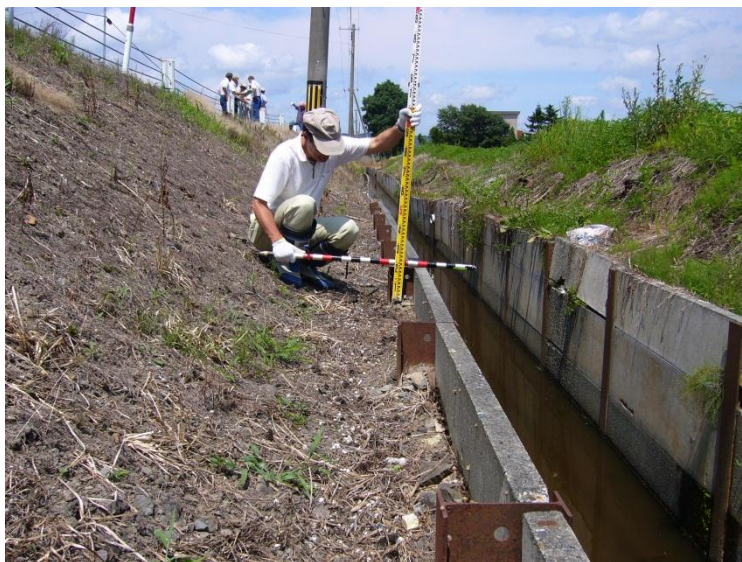
裏込砂利の欠損状況の計測、一部で柵板のガタツキ が見られた。
