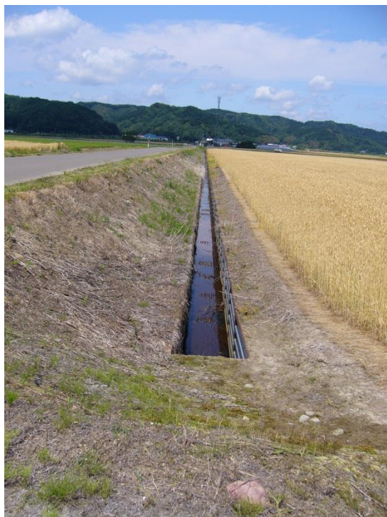
鋼矢板水路区間。異常なし。
