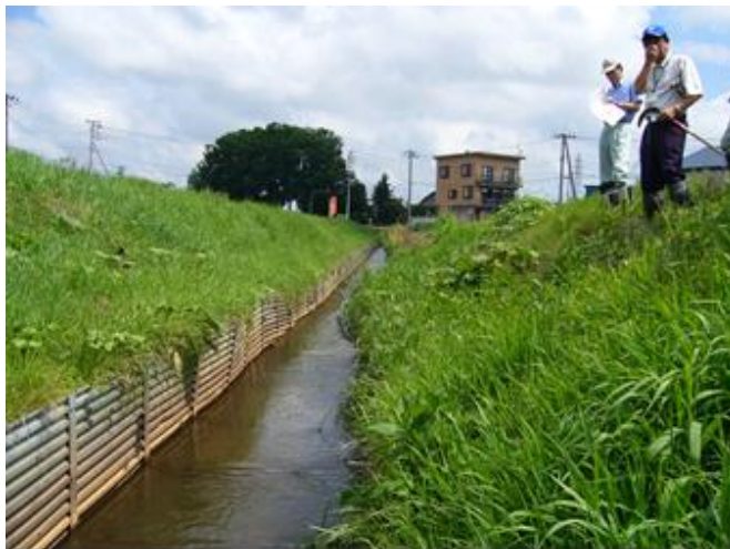
南3号付近の鋼矢板水路区間。一部で鋼矢板の水路へのはらみ出し。
