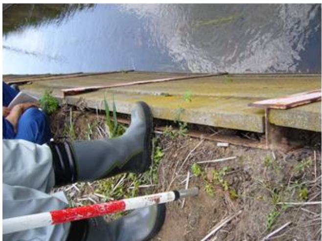
裏込砂利の欠損によるコンクリート柵渠板のガタツキ状況。
