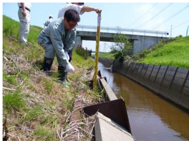
裏込砂利の欠損で柵板のガタツキあり。
