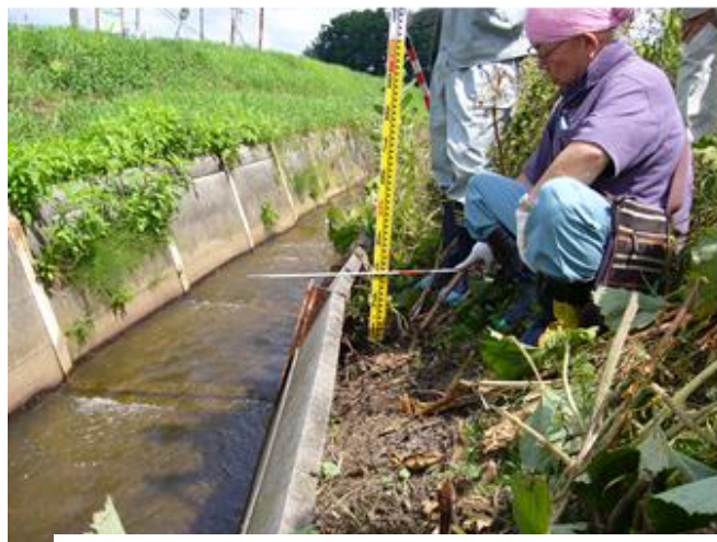
南3号付近のV型コンクリート柵渠
