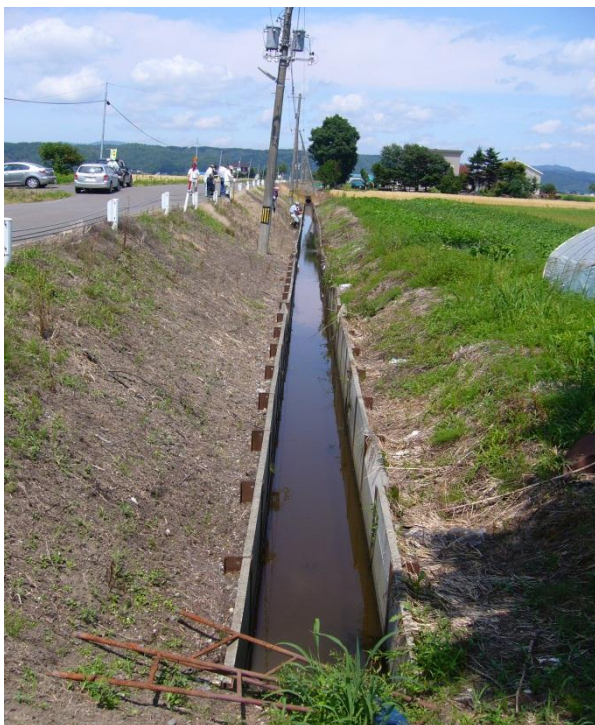
裏込砂利の欠損(圧密沈下のため)、一部で 柵板のガタツキが見られた。
