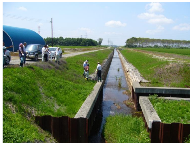
36線南7号より下流の柵渠工。裏込砂利の充填作業済み。3面装工であるが多少の土砂堆積、水草繁茂あり。
