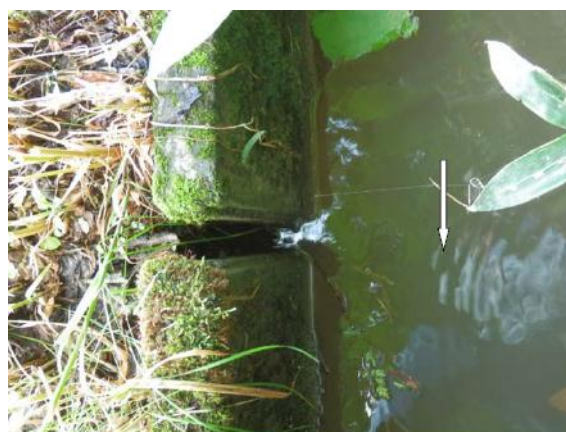
⑫目地欠落・漏水状況
