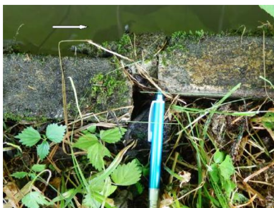
⑩目地及び側壁変位状況 \Delta=30\text{mm}
