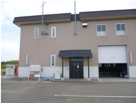
揚水機場上屋外観
