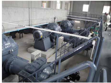
揚水機場内部
