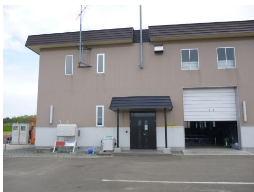
【北生振揚水機場写真】
