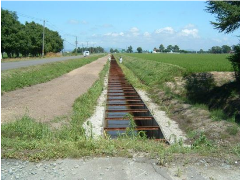
裏込砂利の充填作業済み区間。水路は安定した状況である。
