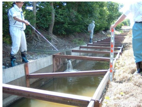
H網切梁の状況（外れて機能していない箇所あり）
