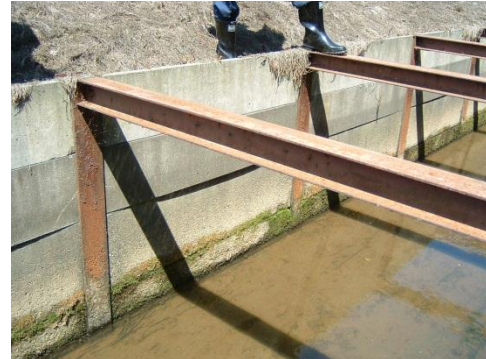
柵渠板の状況（はらみ出しが少し発生）
