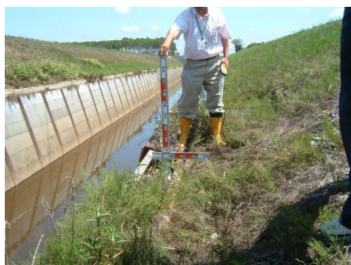
裏込砂利の沈下状況（約20cm程度沈下）
