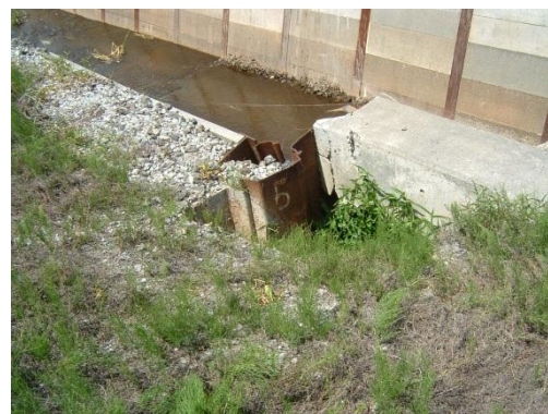
止水壁部（網矢板）の状況（裏側の土砂が流失している）
