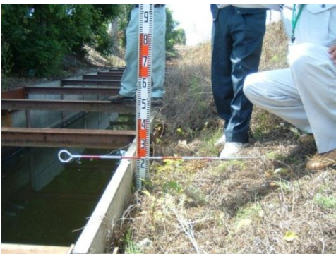
裏込砂利の沈下状況（20cm程度沈下）
