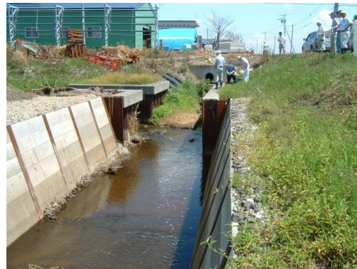
調査終点部の状況（水路底に土砂が堆積）
