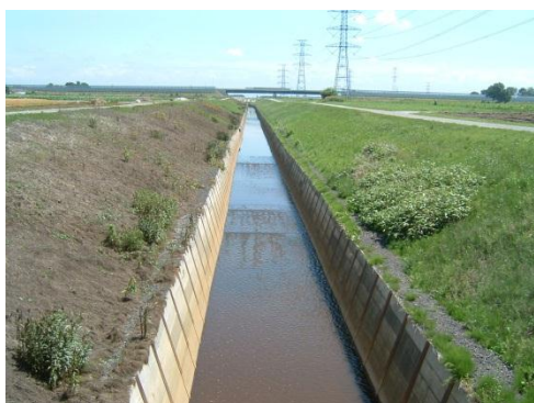
裏込砂利の充填作業済み区間（多少水路底の不陸が見られる）
