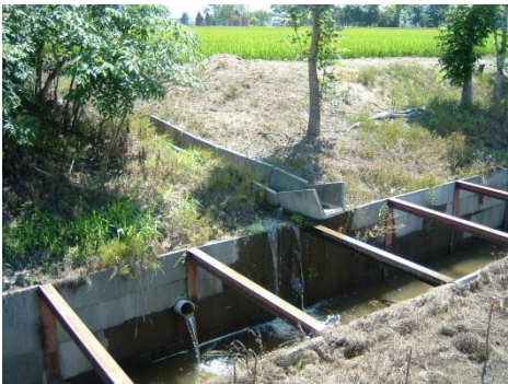
流入工の状況（排水路接続トラフ水路が壊れている）
