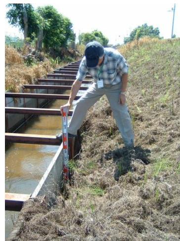
裏込砂利の沈下状況（70cm程度沈下）
