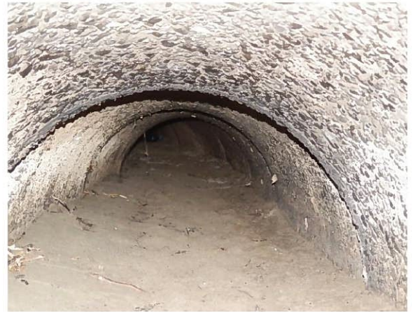
出口部の管内※ 25cm 堆砂している
