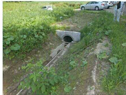
勾配変化位置の取付道路
