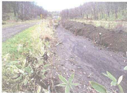
水路閉塞状況
