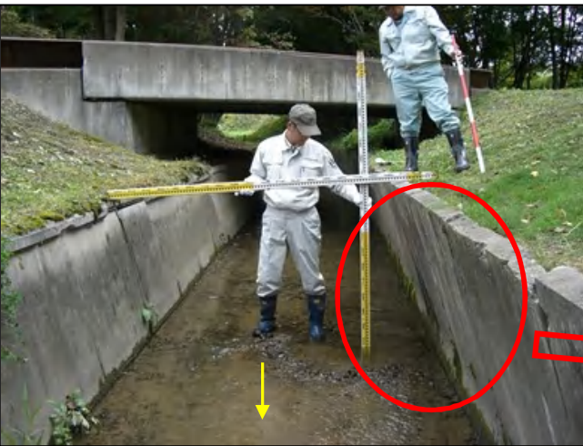
⑨ SP1,060断面(上幅 設2.66m 実1.91m)
