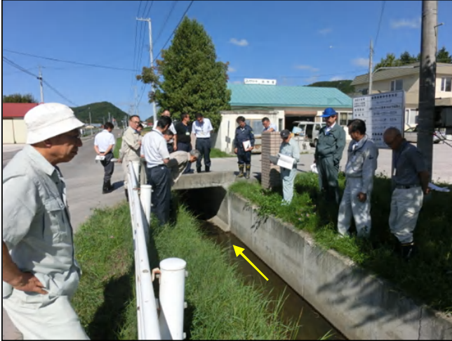
① 点検活動状況（SP60付近 第1号函渠工）
