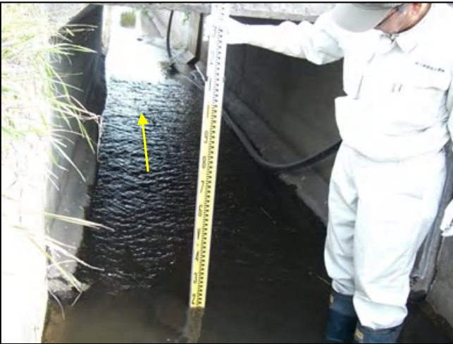
⑨ 第2号函渠工 上流側段差 T=13cm
