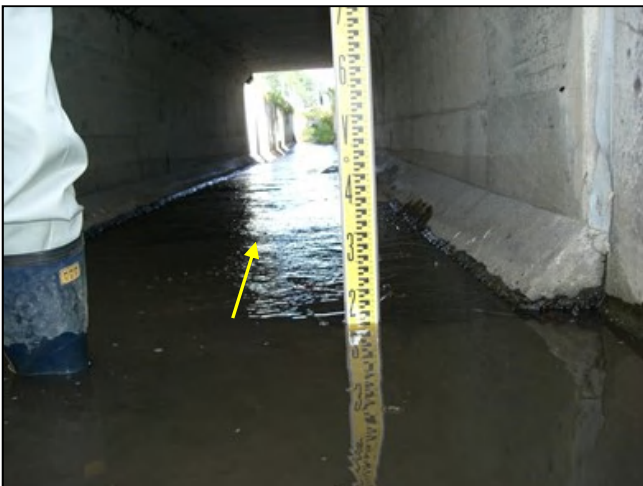
⑤ 第1号函渠工 上流側段差 T=13cm
