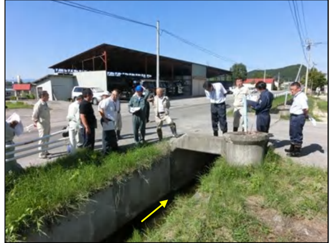
② 点検活動状況（SP130付近 第2号函渠工）
