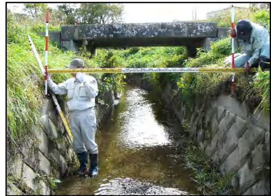
B型（L型ブロック）装工部（SP700） F型（積ブロック部）装工部（SP800）
