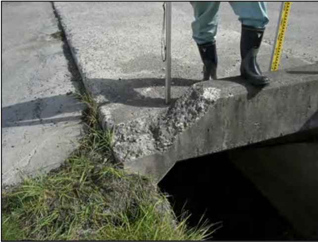
⑪ 第2号函渠工 擁壁破損状況
