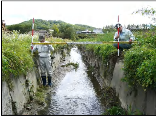
B型（L型ブロック）装工部（SP700） F型（積ブロック部）装工部（SP800）
