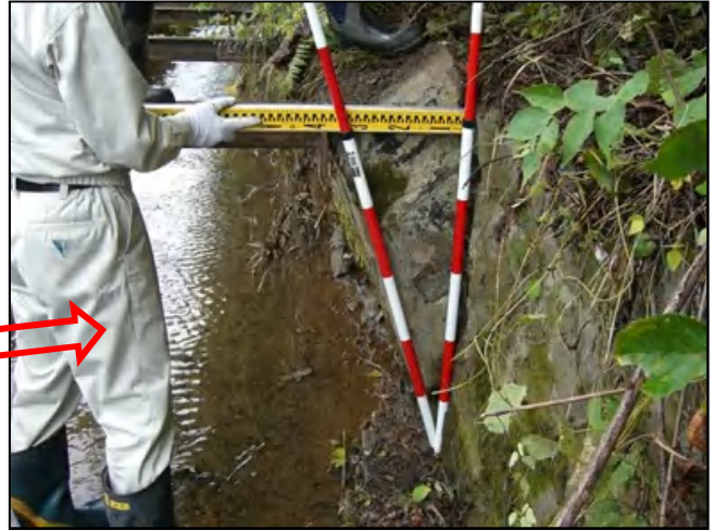
⑧ 積ブロック傾斜状況 SP940
