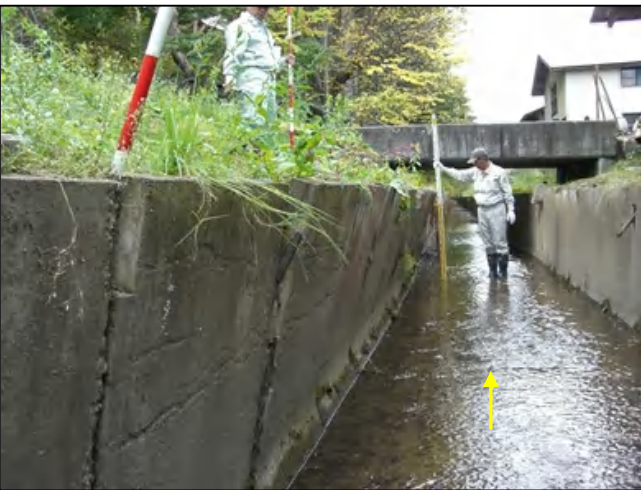
⑪ SP1,020 L型トラフ傾斜状況
