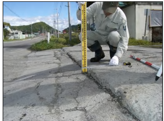
⑥ 第1号函渠工 取付道路段差 T=6cm
