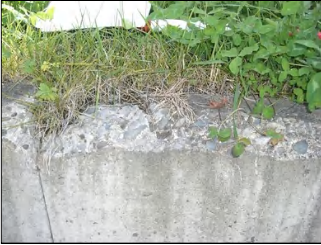
⑦ フリューム天端部分破損状況
