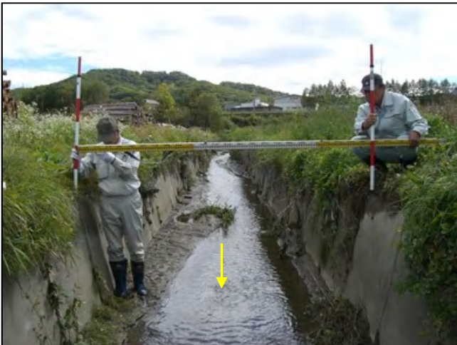
⑤ SP700断面(上幅 設2.66m 実2.45m)
