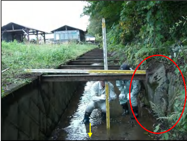
⑦ SP940断面(上幅 設2.62m 実1.80m)
