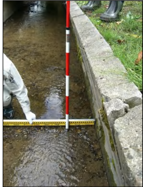
⑩ L型ブロック傾斜状況
