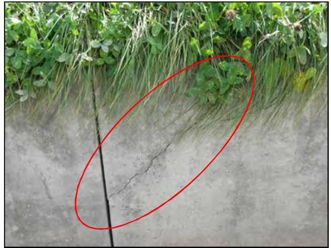
⑧ 側壁クラック状況
