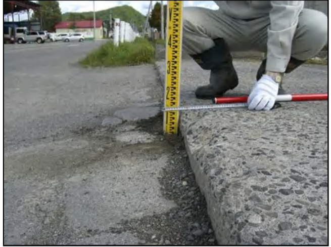
⑩ 第2号函渠工 取付道路段差 T=11cm
