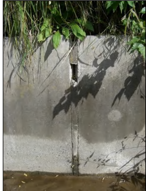
⑫ L型ブロック目地状況
