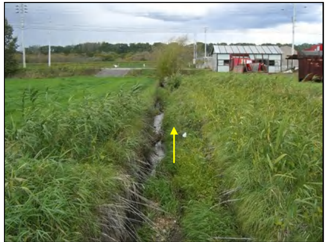
④ 堆砂状況（SP600付近）
