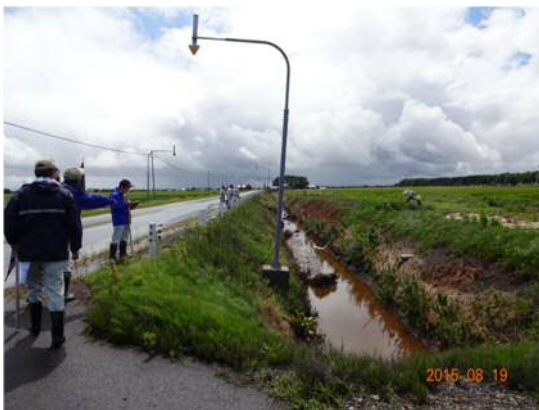
法面が沈下し大型視線誘導標が不安定
