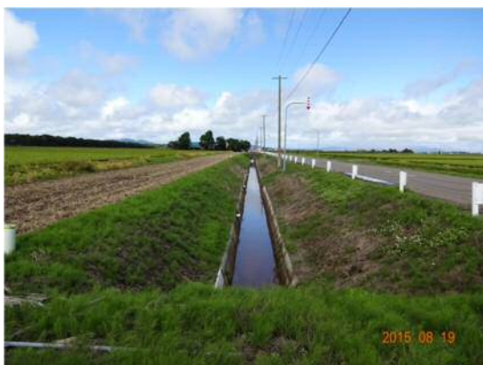
コンクリート柵渠全景
