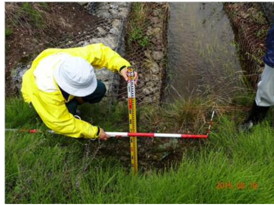
取付道路横断管の盛土法面部の土砂流出
