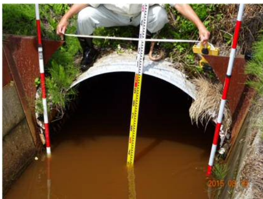
コルゲートパイプ 30cm 沈下
