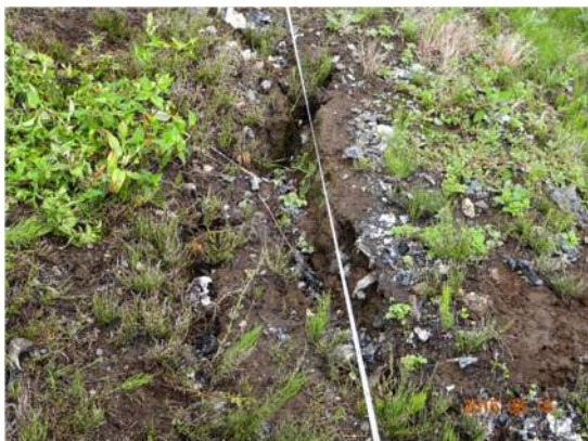
法面部の亀裂状況
