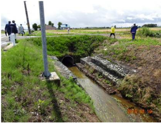
土砂流出全景
