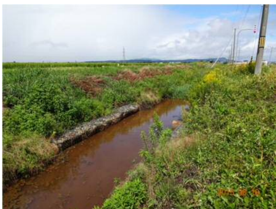
法尻保護のためフトン籠設置状況
