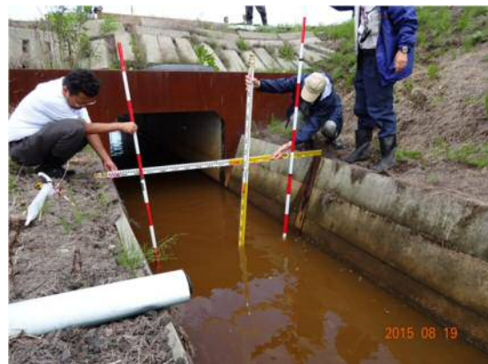
柵渠断面 上幅 1.9m 下幅 1.2m 高 1.2m
