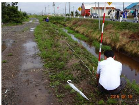
法面部に亀裂あり L=30m
