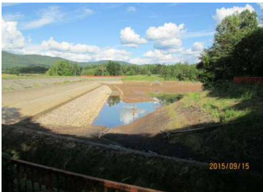
貯水池左岸から堤体全景
