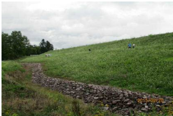
下流側堤体の法面
