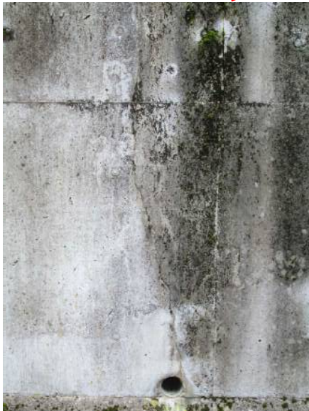
移行部のクラック
