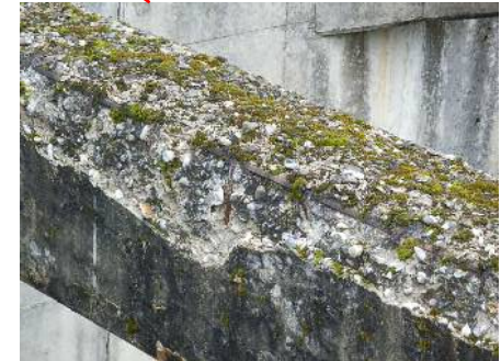
減勢エストラットの劣化
