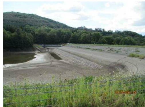
右岸から堤体全景
