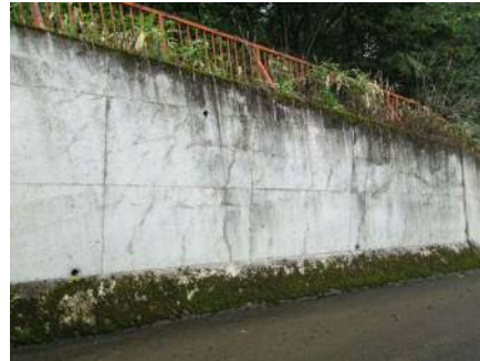
2スパンにひび割れが目立つ
