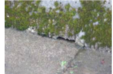
底板とハンチ部分に隙間が開いている。凍結による弱点となるので補修を要する
