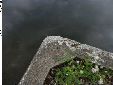
コンクリートの劣化
