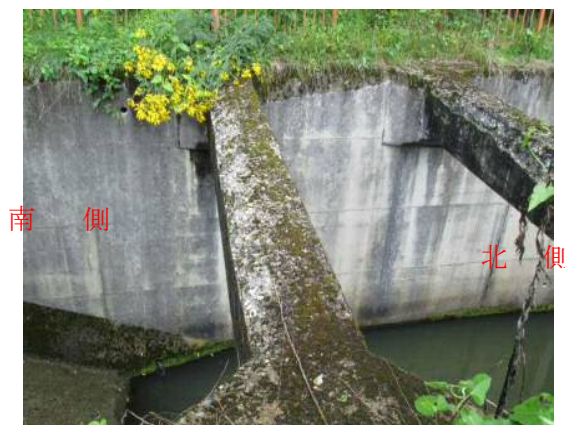
寒冷地で南向きの部材は、表面が乾燥し内面が湿潤のままになると凍害を起こしやすい
