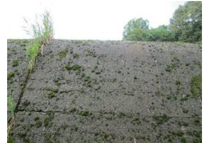
越流堰の摩耗状態
