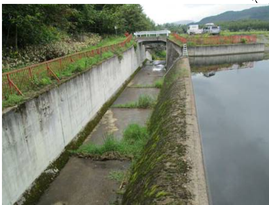
① 流入部上流側より
