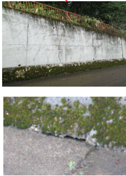
ハンチの隙間
