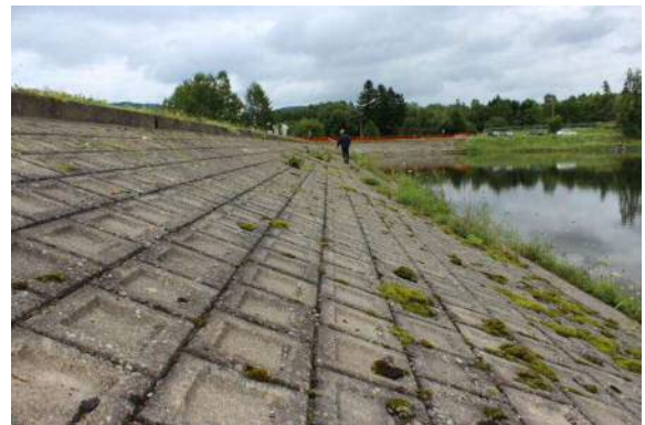
上流側張りブロック法面
