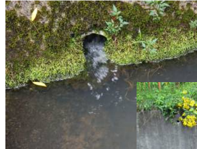
壁背面からの流入水
