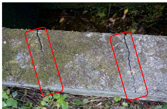
写真 3-2-10 右岸擁壁クラックの状況
