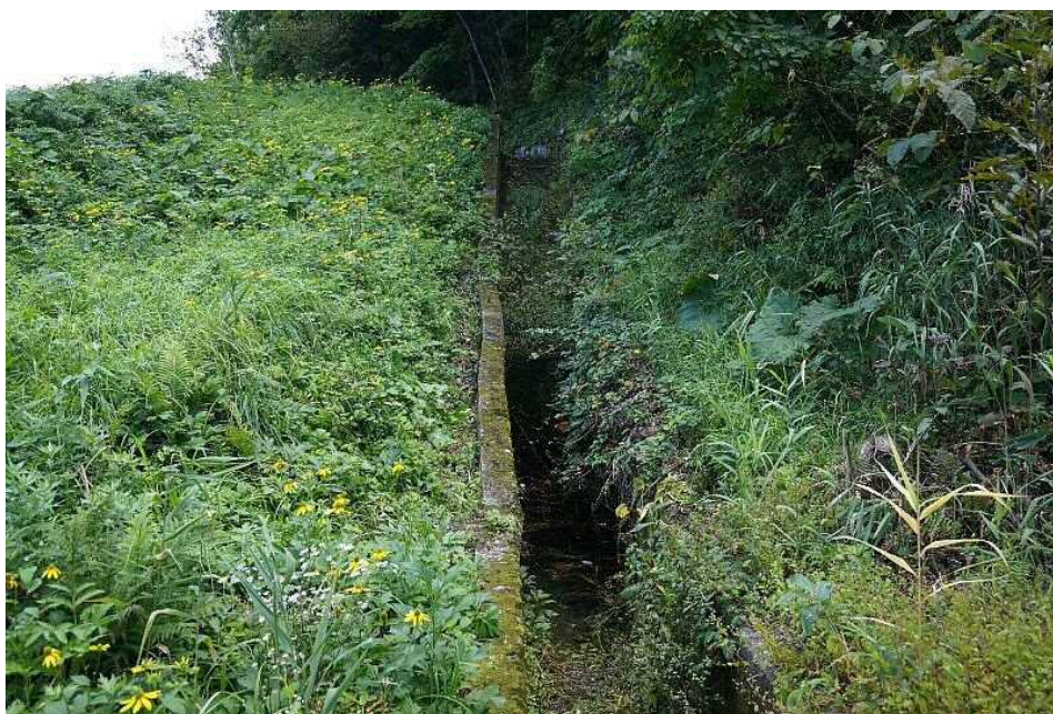
写真 3-2-1 洪水吐急流部
