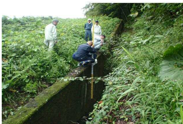
写真 3-2-2 洪水吐減勢工傾斜測定（NO3）
