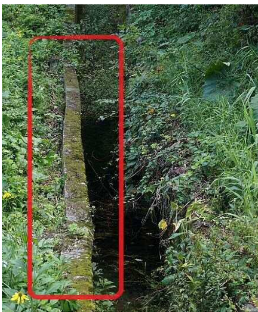
写真 3-2-4 減勢工右岸の波打ち
