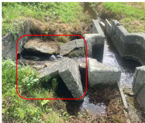
写真 3-3-5 底樋吐出部・取付水路
