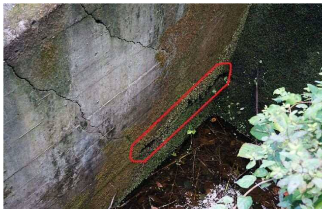
写真 3-2-8 右岸打ち継ぎ目に平行な空隙
