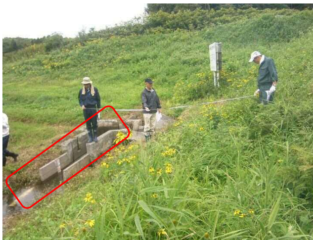
写真 3-3-6 底樋吐出部・導水路部 健全度ランク S-3
