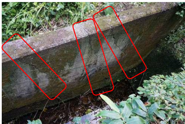
写真 3-2-7 右岸縦方向のクラック
