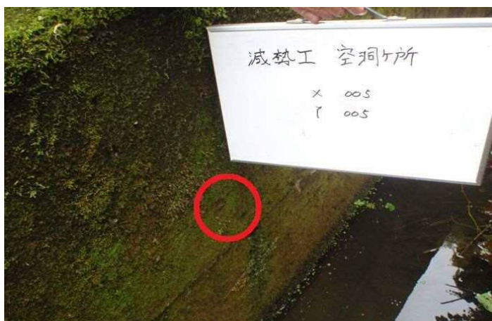
写真 3-2-6 減勢工空洞カ所（コンクリート強度試験
