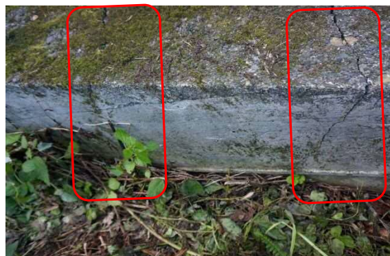
写真 3-2-11 右岸擁壁クラックの状況
