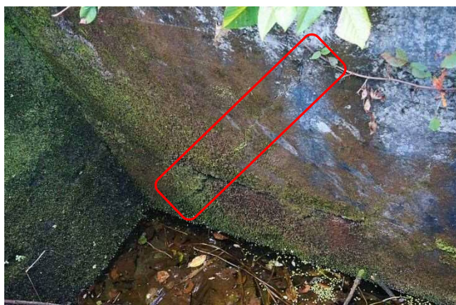
写真 3-2-9 左岸縦方向のクラック
