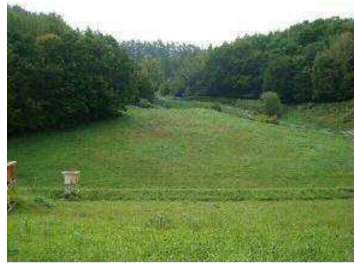
堤体下流部、堤頂より
