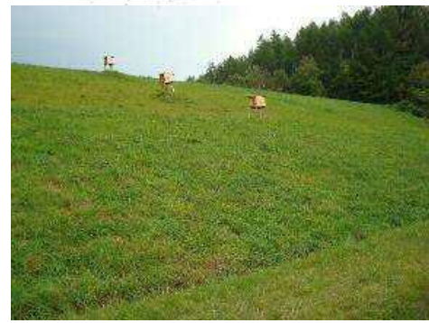
堤体下流法面 中央～左岸側
