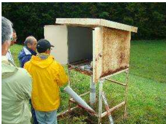
浸潤線観測施設
