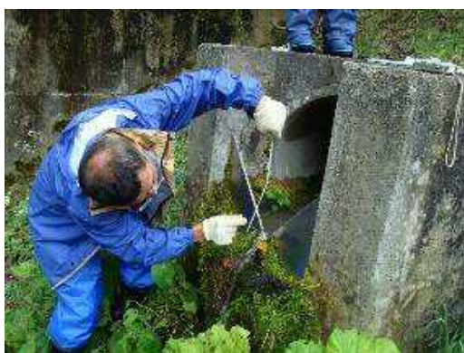
漏水量測定状況
