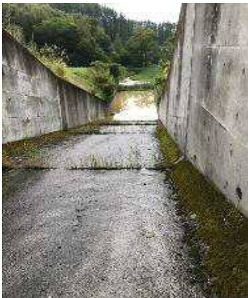
流入部～放水路部
