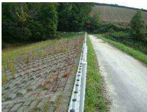
堤頂～上流法面 右岸側より
