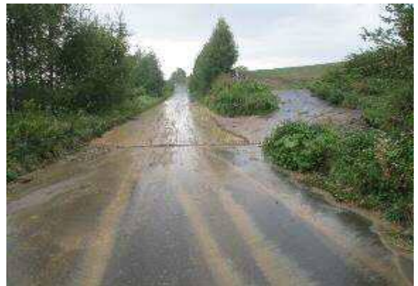
道路への土砂流出 写真2
