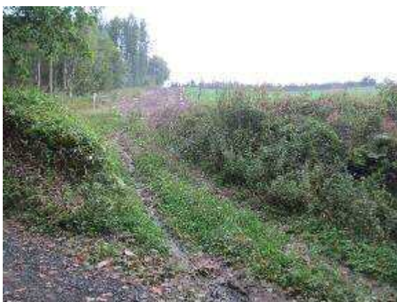
農地からの土砂流出 写真3
