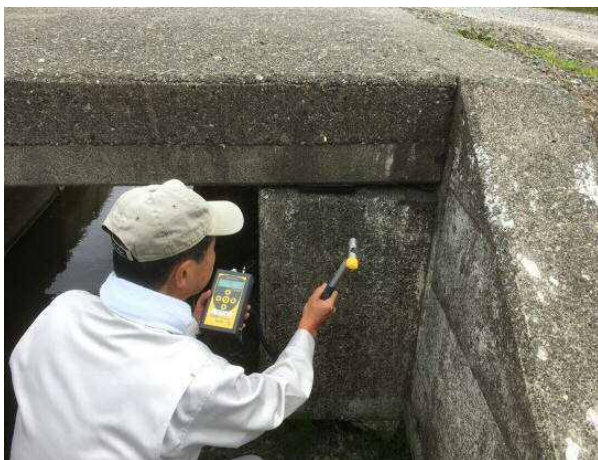
コンクリートテスターによる強度確認状況
