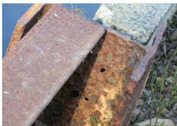
H形鋼親柱腐食状況
