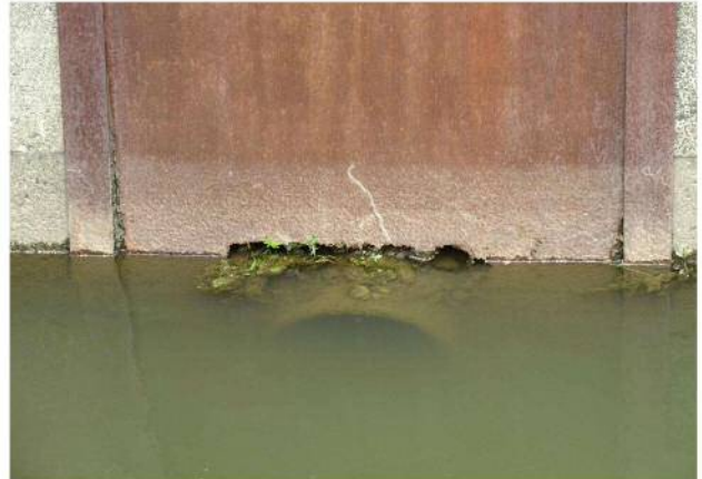
鋼板の腐食状況（流入工）
