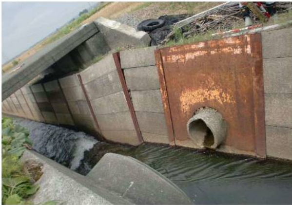
流入工の状況
