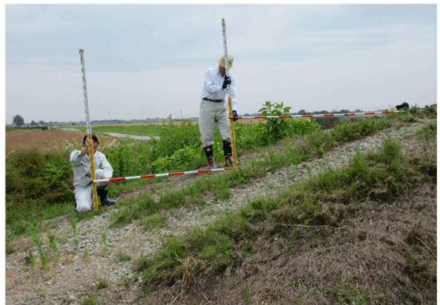
橋梁取付急勾配状況
