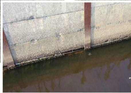
柵渠板損傷状況
