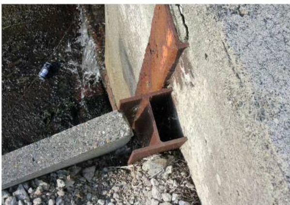
沈下による柵板の掛かり状況
