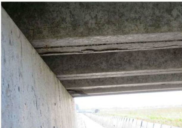
橋梁エスラブクラック状況
