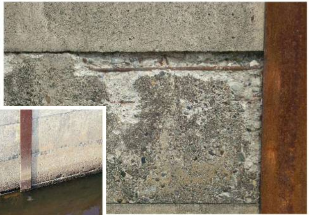
柵渠板損傷状況
