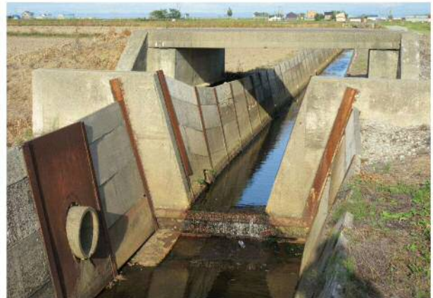
断面変化止水壁部前後沈下状況
