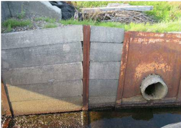
流入工前後の沈下状況
