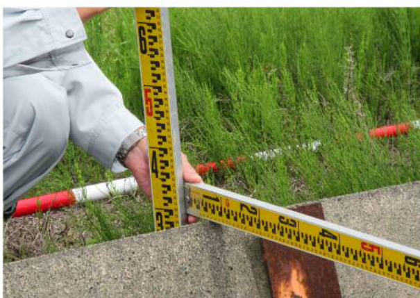
裏込砂利沈下状況
