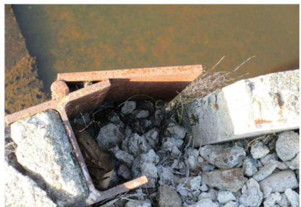
沈下対策の状況（鋼板の継足し）
