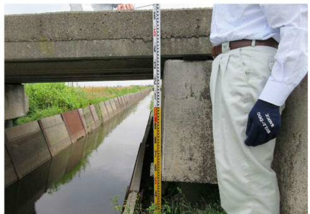
橋台下部（裏込砂利）沈下状況
