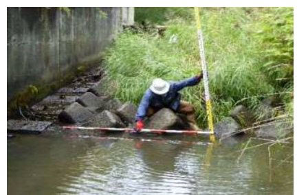
護床工最下流状況2
