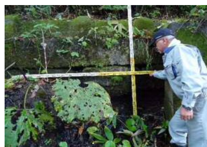
基礎工隙間状況
