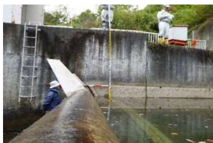
転倒堰全閉時高背面
