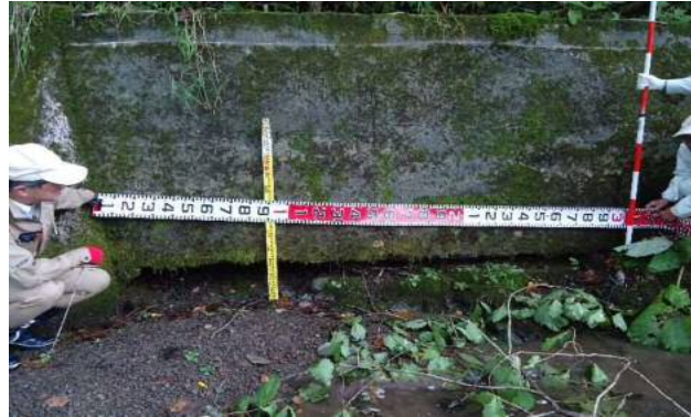
護岸工洗堀ヶ所
