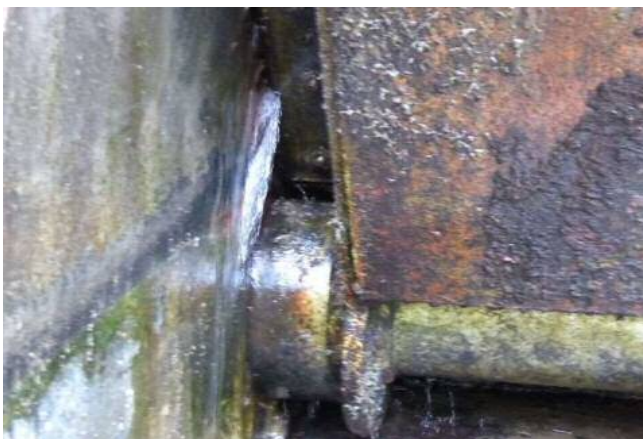
扉体側部(右岸)
