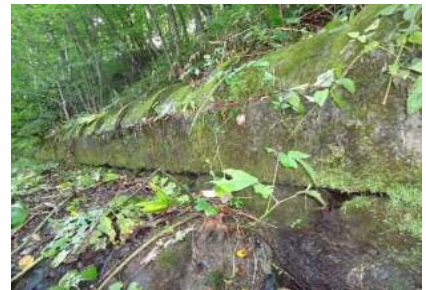
基礎工隙間状況
