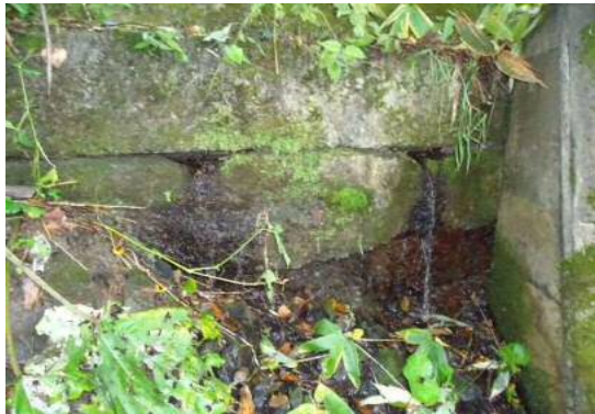
管渠工(φ600)漏水状況
