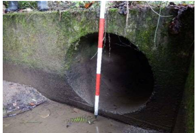
RC管吐口現況
