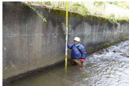
護床ブロック下流右岸側状況2
