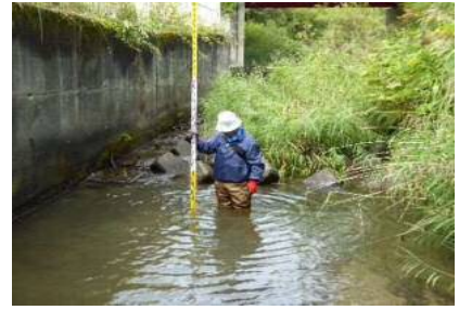
護床ブロック下流右岸側状況3
