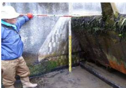
転倒堰全閉時高背面
