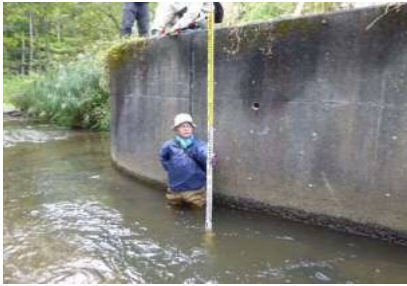
護床ブロック下流右岸側状況1
