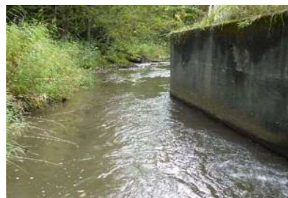
擁壁工右岸側
