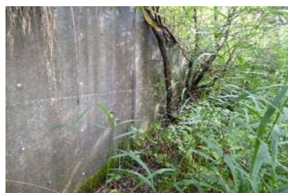
擁壁工左岸側
