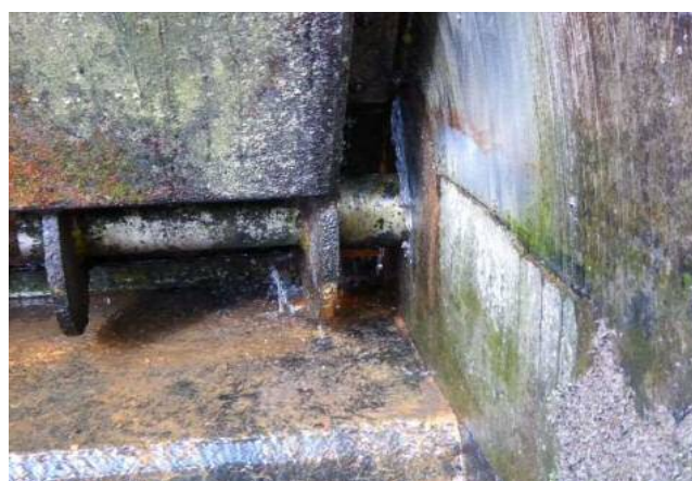
扉体側部(左岸)
