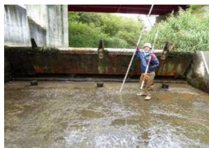
転倒堰全閉時背面全景
