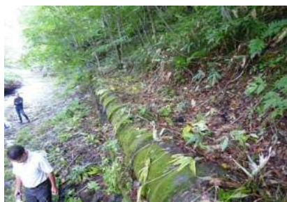
管渠工(φ600)現況及び隙間状況
