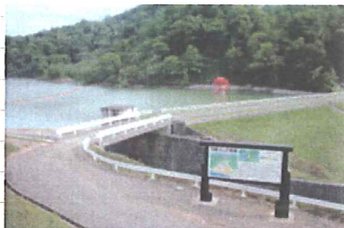
羽幌ダム（羽幌鉦）
