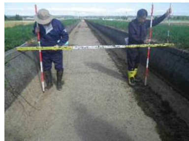
⑱sp133.6(R)笠コンクリート傾斜-13° 確認
