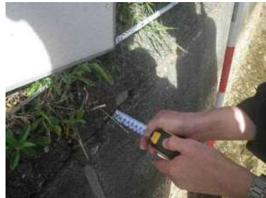
⑩ sp42.4L 型ブロックと底版コンクリートに隙間 6mm 確認
