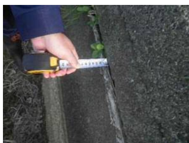
④⑬sp717.8(L) 笠コンクリートの段差 3cm 確認
