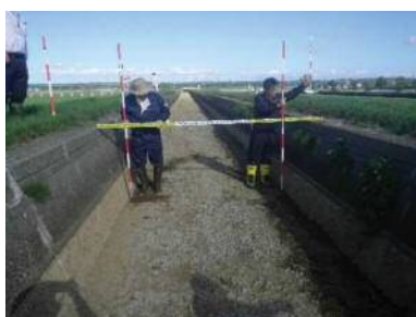
④⑭sp744 (L) 笠コンクリートの横ズレ 7cm 確認
