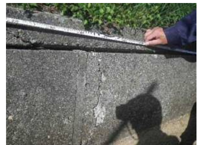
⑫ sp42.4 (L) 側壁の剥離を確認
