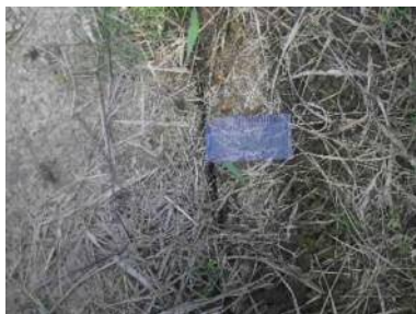
⑳sp133.6(R)目地隙間 3mm 確認
