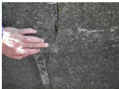
④⑩ sp676(R) 笠コンクリートの横ズレ 1.5cm 確認
