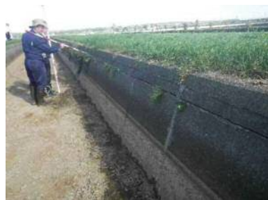
④⑫ sp717.8(L) 笠コンクリートの傾斜 -12° 確認
