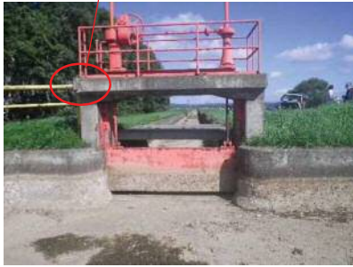
④ sp5.35 底版の目地欠損を確認
