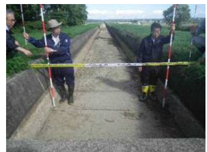
⑥ sp25.4(R)笠コンクリート浮き上がり確認
