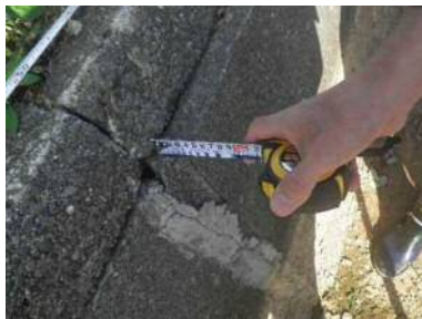
⑰sp133.6 L 型ブロックと底版コンクリートに隙間 5mm 確認
