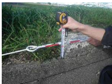
③④sp534.5 笠コンクリートの嵩上げ補修13cm 確認
