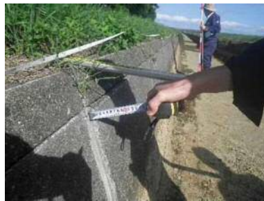
⑧ sp35.3 (R) 側壁傾倒 1.5cm 確認
