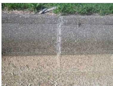
③②sp500(L)側壁の摩耗状況
