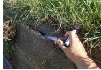
⑥ sp1604R 側 空洞にテープが縦 90cm 入る
