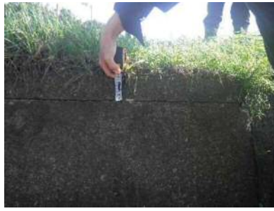
⑤ sp25.4 (L) 側壁傾倒 2cm 確認
