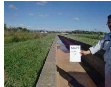
⑪ Sp1900 から下流を撮影 下流に水溜り確認（水深約1cm）
