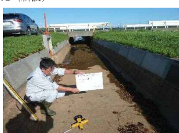
⑭sp1400～sp1411 L型ブロック布設替え(新設)
