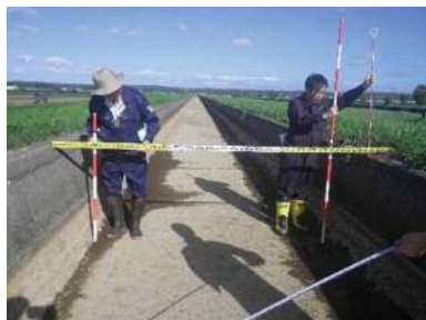
③④sp534.5 笠コンクリートの嵩上げ補修13cm 確認
