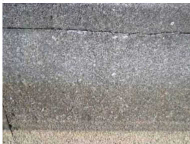
③⑤sp556-594 区間の沈下状況を確認
