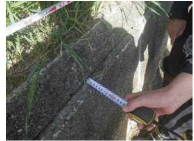
⑫ sp42.4 (L) 側壁の剥離を確認
