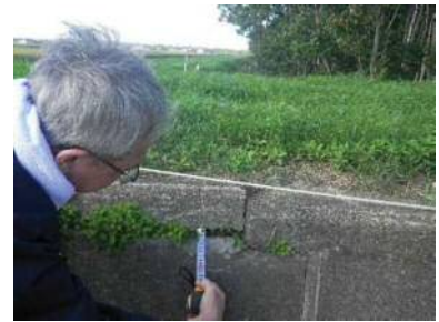
⑨ sp41 (L) 側壁傾倒 3.5cm 確認
