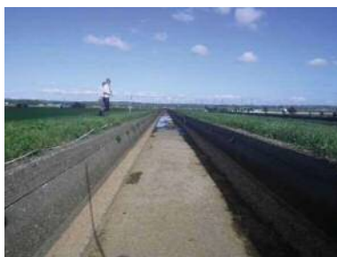
③⑤sp556-594 区間の沈下状況を確認
