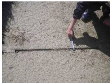
⑦ sp35.3 (L) 側壁傾倒 1.3cm 確認
