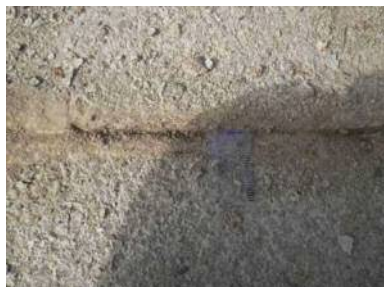
⑲sp133.6(R)笠コンクリート浮き上がり 3.5cm 確認
