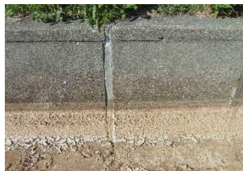
④sp868～sp919(L)笠コンクリートの表面剥離
