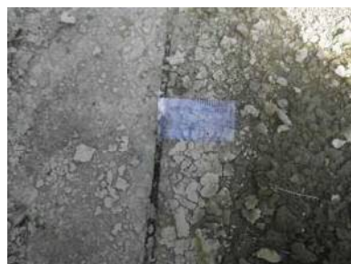
⑩ sp42.4L 型ブロックと底版コンクリートに隙間 6mm 確認
