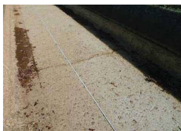
⑭sp1400～sp1411 L型ブロック布設替え(新設)
