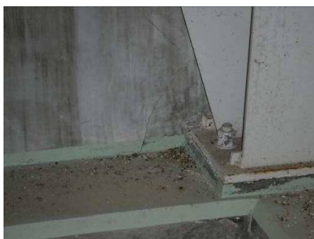
写真－10 東側下部壁面ひびわれ
