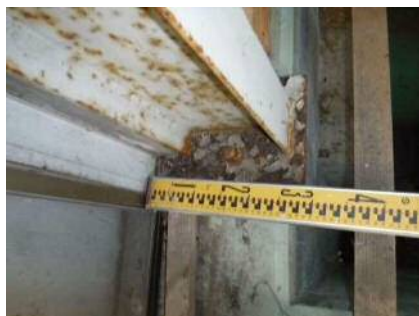
写真-4 南側中央柱下部
