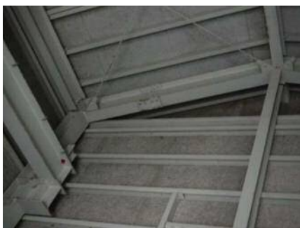
写真-12 屋根内側(南側)
