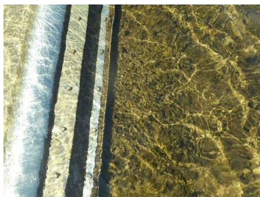
コンクリートの細粒分摩耗・粗粒分露出しているがハンマーでたたいても剥離は無かった
