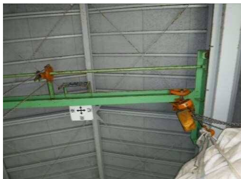
写真－19 屋内クレーン施設
