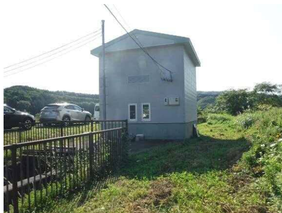
写真2 揚水機場外観(南東面)
