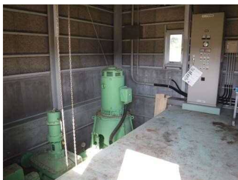
写真－18 (2枚) 受配電施設
