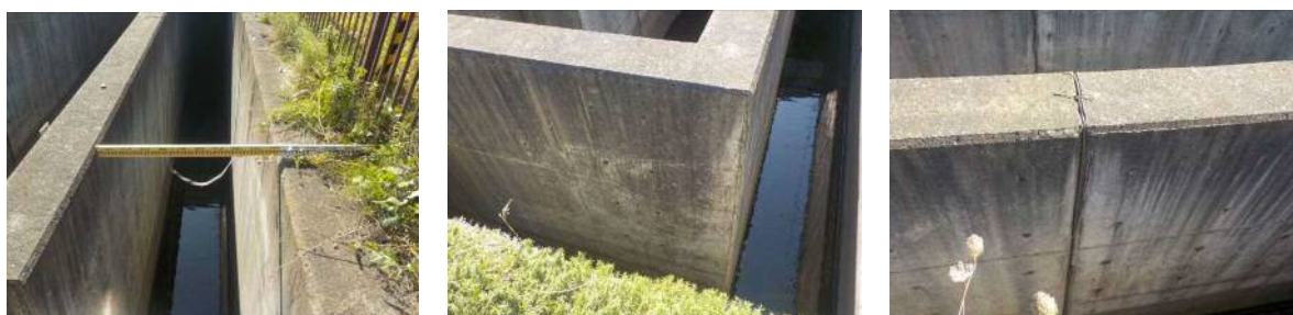
写真-14(3枚) 導水路の状況
