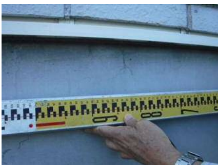
写真－8 東側斜面微細ひびわれ状況
