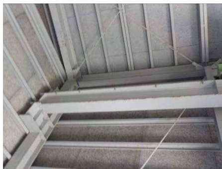
写真-13 屋根内側(東側)
