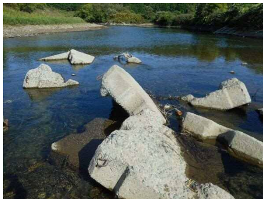
流出及び損壊状況（上流）
