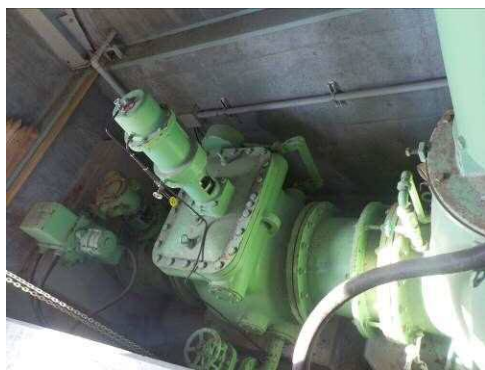
写真－17(2枚) ポンプ施設
