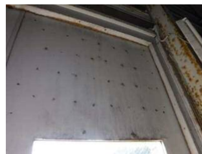
写真-5 玄関扉内側
