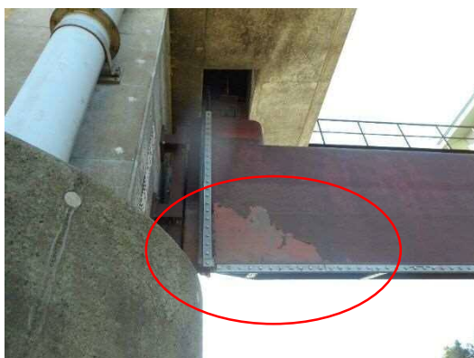
一部塗装剥離あり
