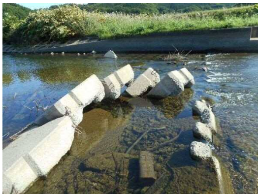
大きくめくれあがっている
