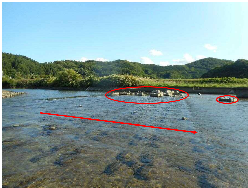
上流左岸側の護床ブロックの流出・損壊を多数確認した
