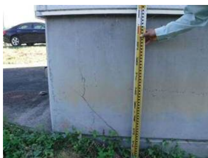
写真－8 東側斜面微細ひびわれ状況
