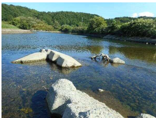
流出及び損壊状況（上流）
