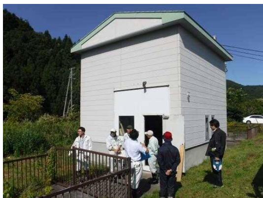
写真1 揚水機場外観(北西面)
