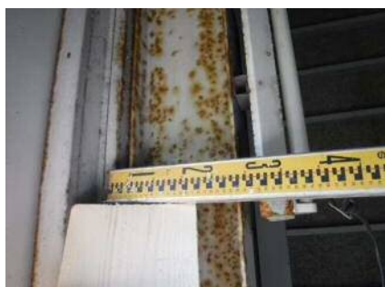
写真-3 錆発生状況(南側中央柱)
