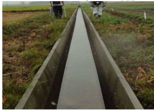
・用水路背面盛土が全線にわたって沈下している。(10～20 c m)
