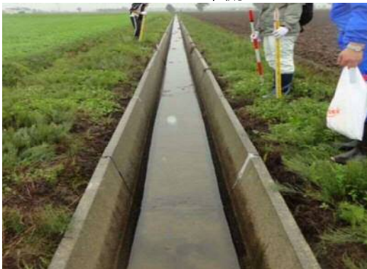
・用水路背面盛土が全線にわたって沈下している。(10～20 c m)
