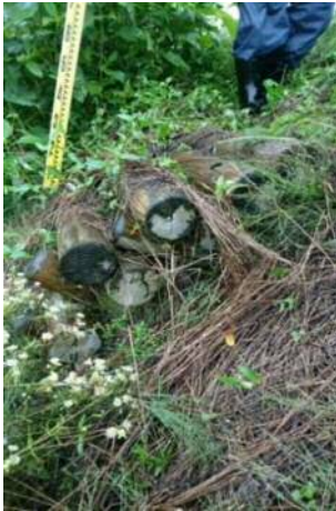
・ SP700 付近 L 側 木製階段工損壊
