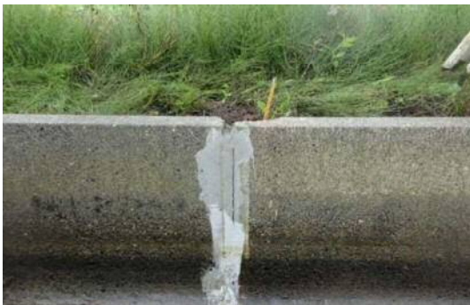
・ 沈下による目地の破損はほとんどない。
