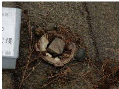
破損状況 SP2700 付近
