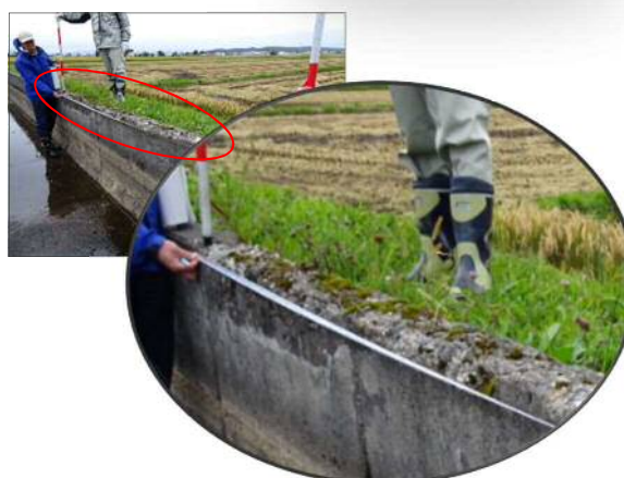
水路側壁天端部 コンクリートの劣化欠損 SP3260(R)
