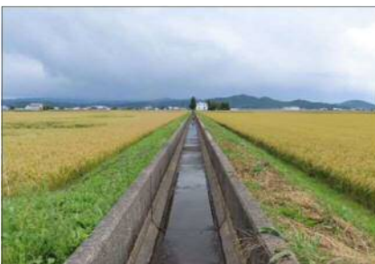
SP4050 から下流方向 沈下・陥没は無い
