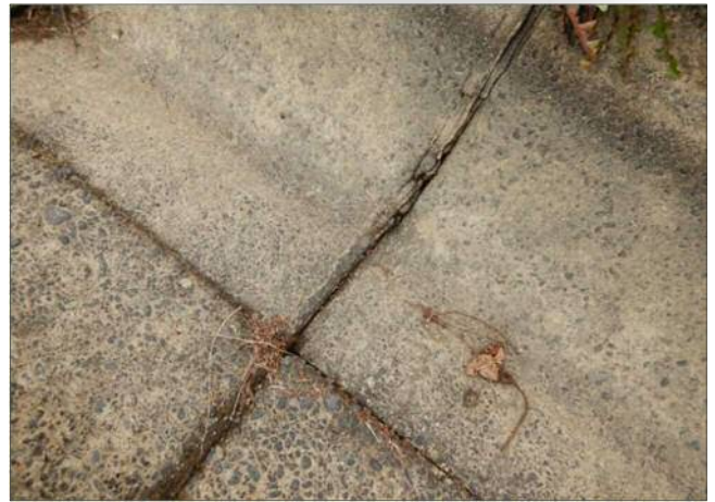
モルタル目地の欠落状況 SP2710(㊦)
