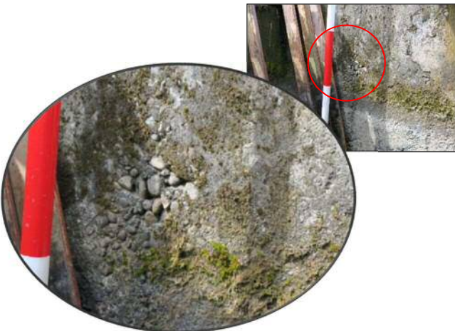
第 1 号逆サイフォン工 右側壁の骨材露出 SP570
