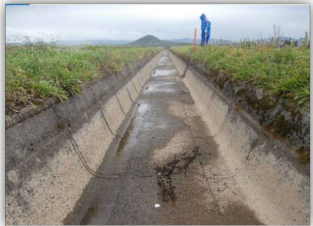
L型ブロック装工 SP950 付近から下流へ
