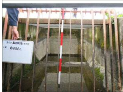
第1号サイフォン工呑口 SP580 スクリーンは異常なし
