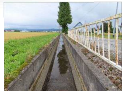
SP4500～下流へ 沈下・蛇行は無い
