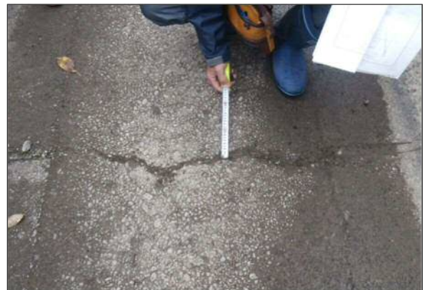
底板コンクリート ひび割れ SP570
