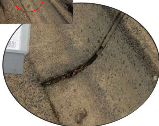
モルタル目地の欠落状況 SP2720(R)
