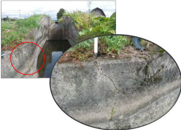
第6落差工 側壁のクラック SP1890(R)
