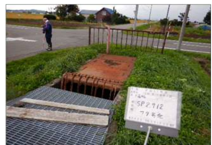
4号サイフォン工呑口 縞鋼板蓋 腐蝕状況 SP2912 付近
