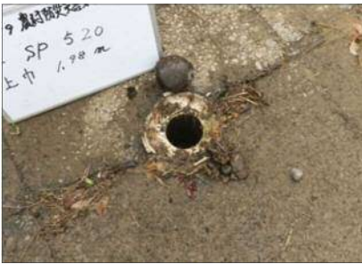
破損状況 SP520 付近
