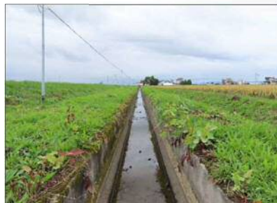
SP4500～下流へ 沈下・蛇行は無い
