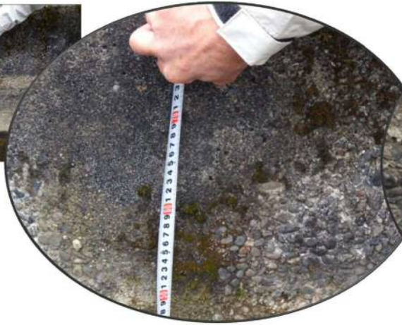
側壁表面の摩耗状況 H=70cm SP3210 付近(L)
