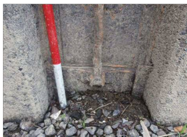
土砂溜工の閉塞で第8号分水ゲート埋塞 SP1121
