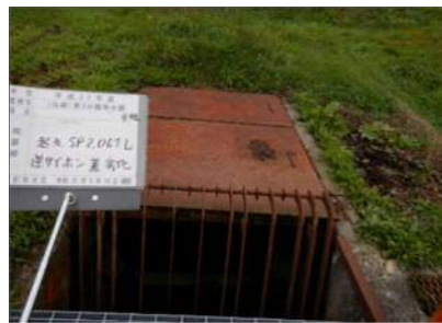
第3号逆サイフォン工呑口 縞鋼板蓋 腐蝕状況 SP2067 付近
