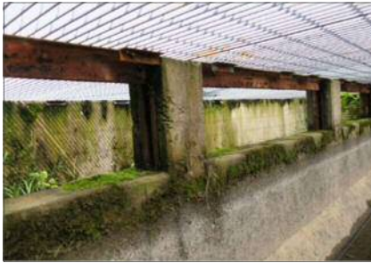
第1号サイフォン工 SP580 付近 グレーチング蓋は異常なし
