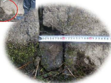
函渠工摺付けコンクリートの欠損 935(R)
