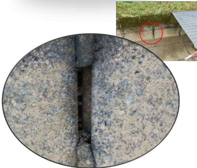
モルタル目地の欠落状況 SP2060(L)
