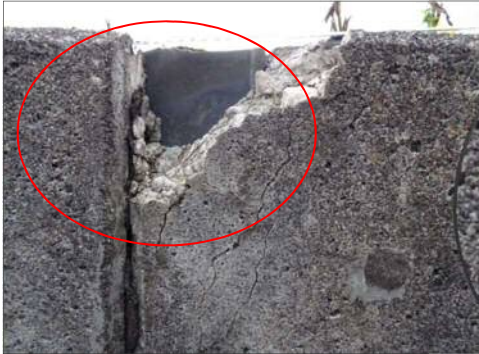
伸縮目地の潰れによる天端部破壊 SP3340(R)
