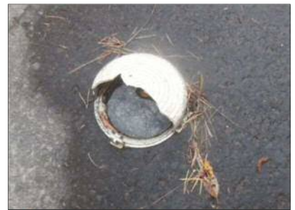
破損状況 SP1360 付近
