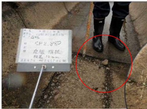
インバートコンクリートの劣化と剥離 SP2880(㊦)
