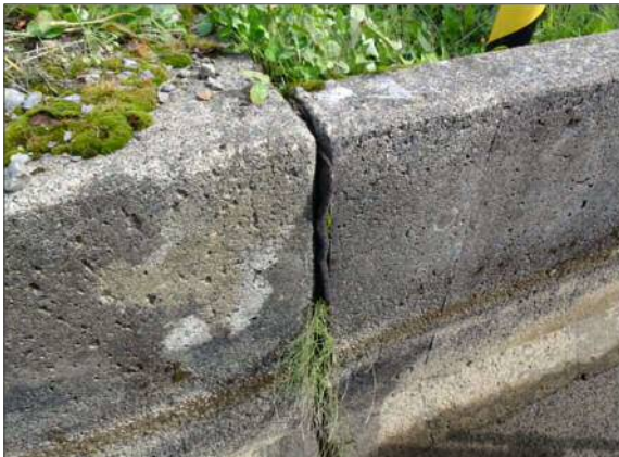
押し出されている伸縮目地(アス系) SP2970(L)
