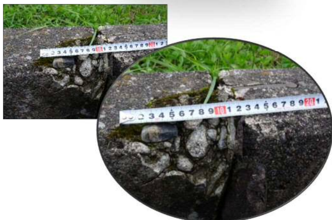
水路側壁天端打ち継部 欠損 SP3350(R)
