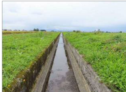
SP3820 から下流方向 沈下・陥没は無い
