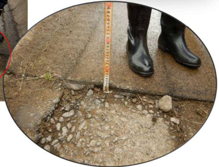
インバートコンクリートの劣化と剥離 SP2880(㊦)
