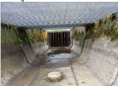
第3号サイフォン工呑口 SP2060 グレーチング蓋スクリーン異常なし
