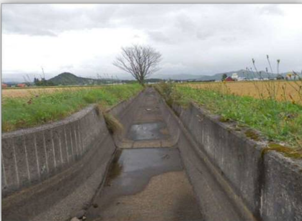
L型ブロック装工 SP1830 付近から下流へ
