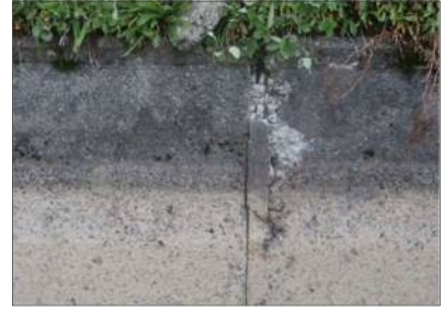
側壁端部の欠損 SP955(L)
