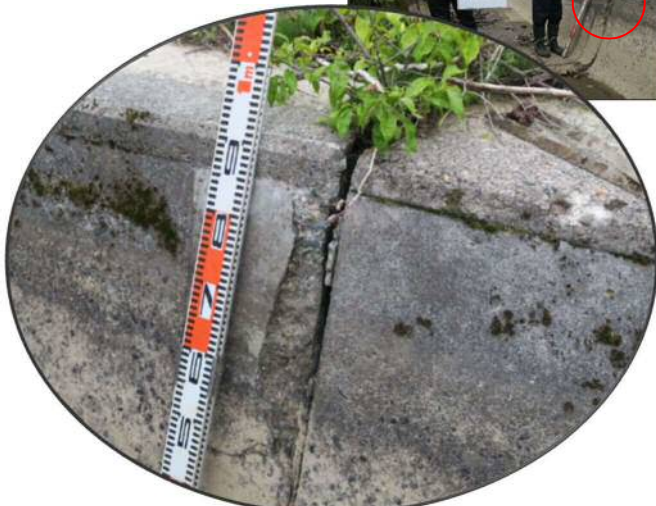
モルタル目地の欠落状況 SP540(R)
