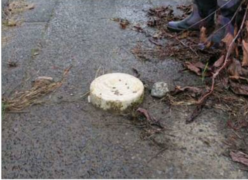
正常なアップリフター(上流側から)
