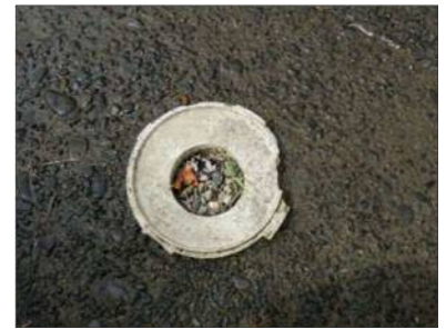
破損状況 SP1500 付近
