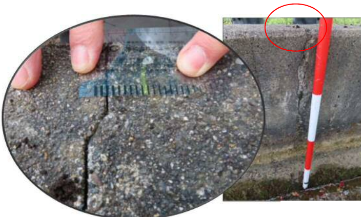
天端・側壁部のクラック状況 1.3 ㍉ SP4450 付近(L)
