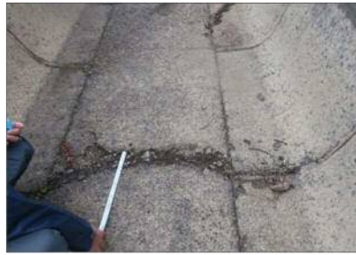
底板コンクリート ひび割れ SP870
