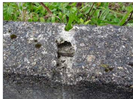
水路側壁の天端部 SP3330(施工不良?欠損あり)
