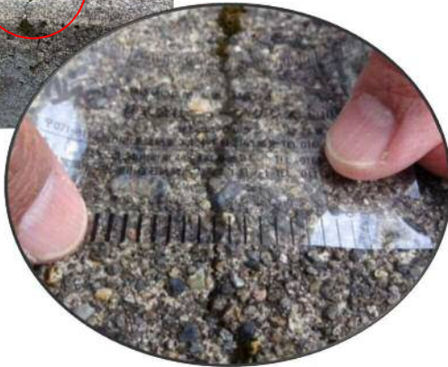
天端側壁部のクラック 0.5 ㍉ SP2970 付近(L)
