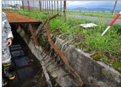
第4号逆サイフォン工吐口 防護柵 腐食倒壊状況 SP2940 付近
