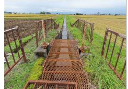
第11号落差工上流側 鉄蓋と防護柵 腐蝕状況 SP3770 付近
