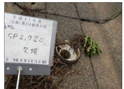
破損状況 SP2720 付近
