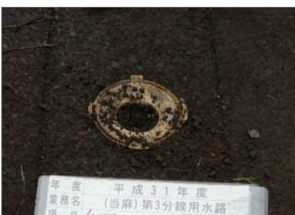
破損状況 SP2450 付近
