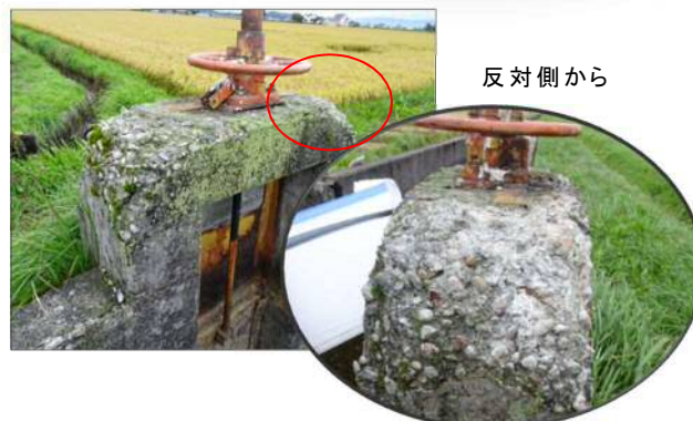
第20号分水工門柱コンクリートの劣化欠損 SP3347 付近(L)
