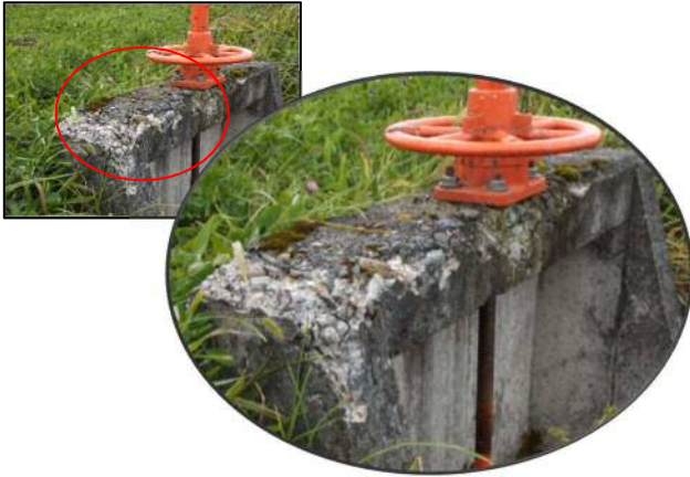
第 8 号分水工門柱 コンクリート劣化 SP907(R)
