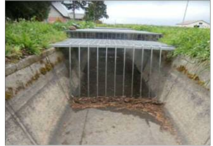
第2号サイフォン工呑口 SP1408 グレーチング蓋スクリーン異常なし
