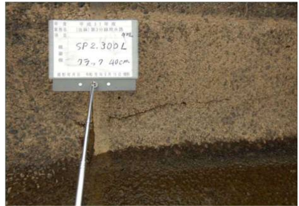
L型ブロック壁面のクラック SP2300(L)
