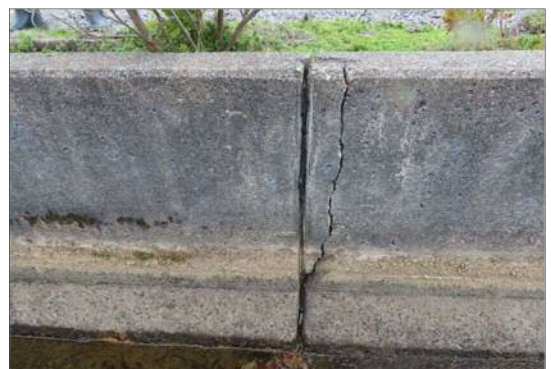
側壁部のクラック状況 SP4390 付近(R)
