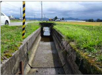
SP2940～下流へ 沈下・蛇行は無い
