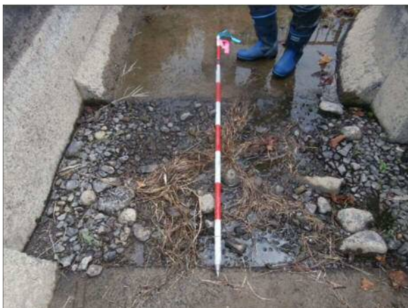
土砂溜工の閉塞状況 SP1121
