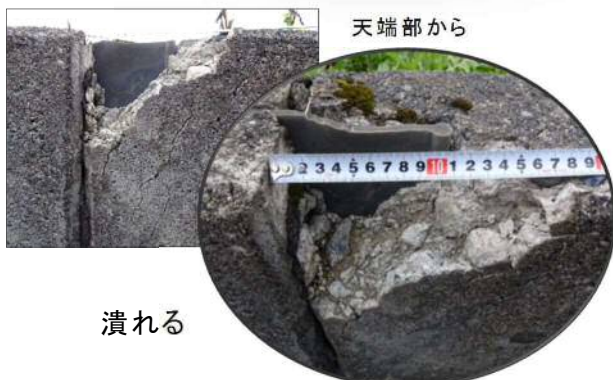
水路側壁天端打ち継部 欠損 SP3340 付近(R)
