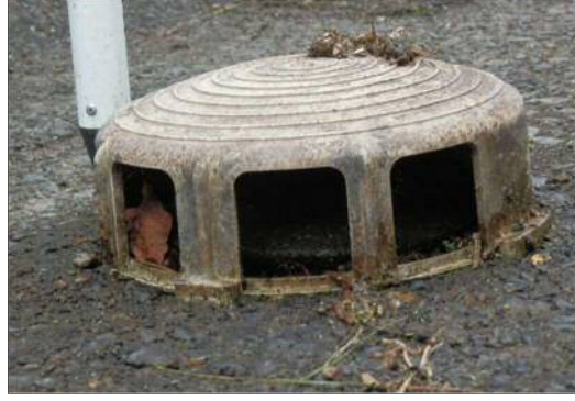
正常なアップリフター(下流側から)
