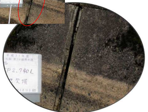
モルタル目地と伸縮目地の状況 SP2740(L)
