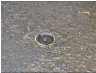
破損状況 SP1400 付近
