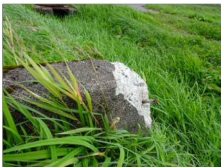
曲部工の止水壁 SP3076(除雪による?損傷)
