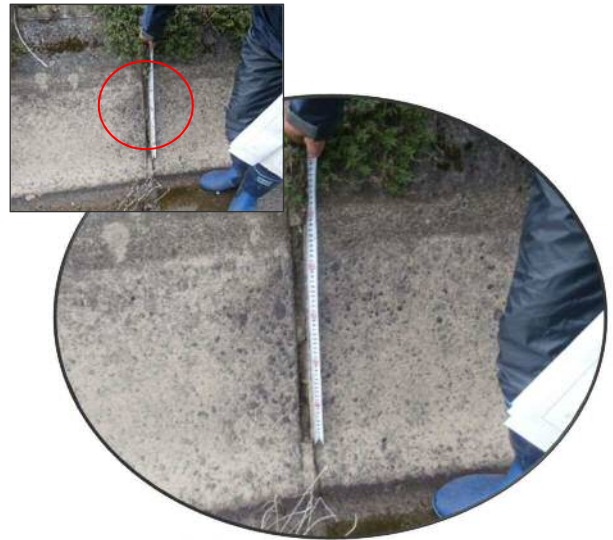
モルタル目地の欠落状況 SPOOO(O)
