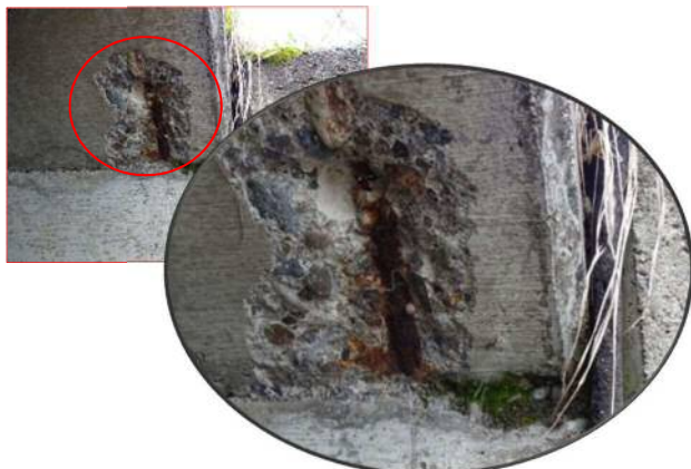
第9号函渠工 下流側ハンチ部分の鉄筋露出 SP2978 付近
