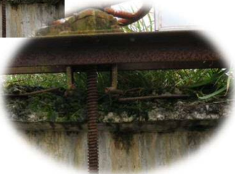
第 2 号分水工門柱 コンクリートの劣化による剥離 SP440
