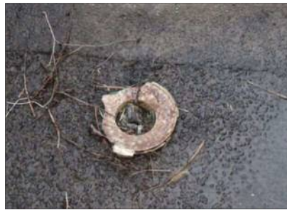
破損状況 SP880 付近
