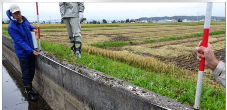
側壁天端部の劣化状況 SP3260 付近(R)
