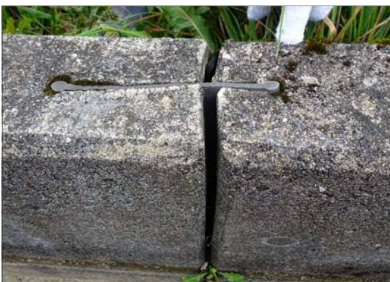
止水板と欠損した伸縮目地の状況 SP2970(L)
