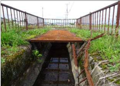
第4号逆サイフォン工吐口 鉄蓋 腐蝕状況 SP3787 付近
