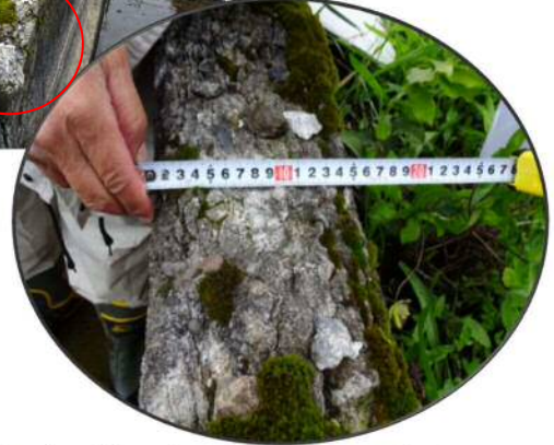
側壁天端部の劣化状況 SP3130 付近(L)
