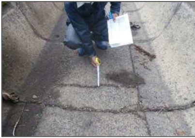
底板コンクリート ひび割れ SP805
