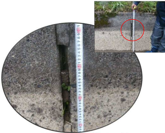
モルタル目地の欠落状況 SP985(L)
