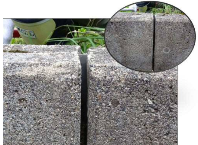
欠損した伸縮目地(アス系) SP2970(L)
