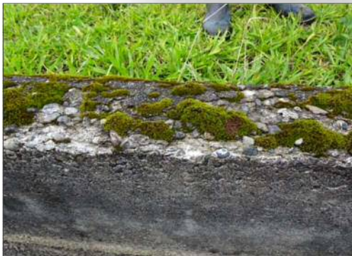
側壁天端部の劣化状況 SP3100 付近(R)
