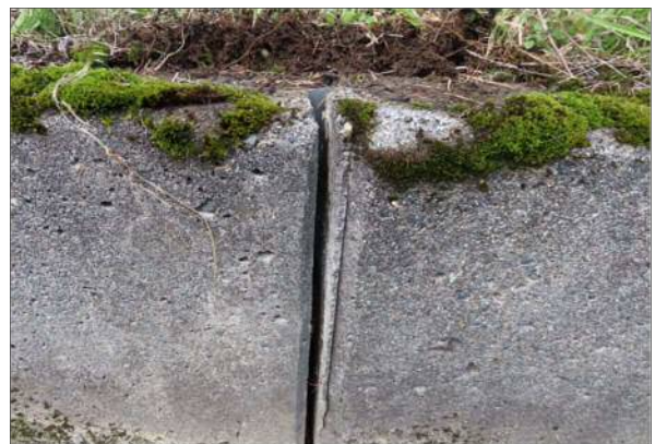
欠損した伸縮目地(アス系) SP4600(R)
