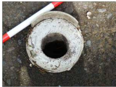
破損状況 SP1500 付近
