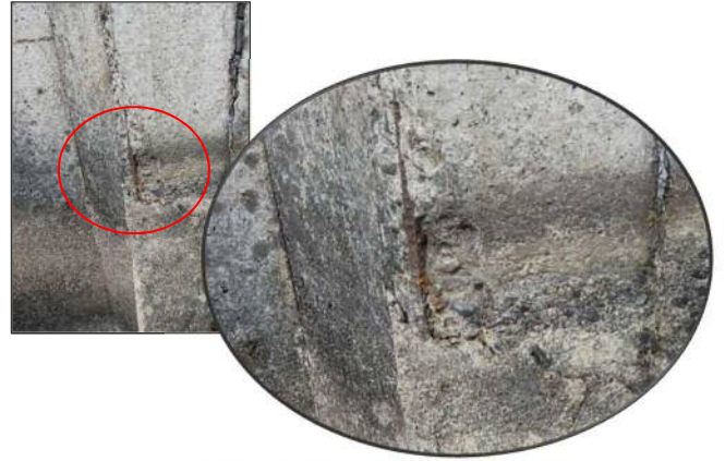
第 5 落差工の側壁 欠損による鉄筋の露出 SP1500
