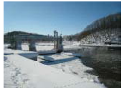
流雪水を取水する頭首工。協定に基づき冬期間も水土里ネットが管理
