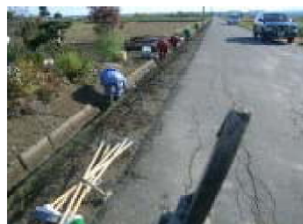
開水路の簡易な補修作業
