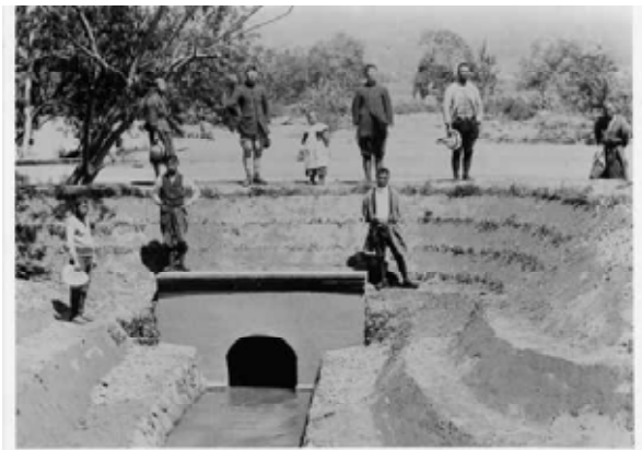
大正6年、元浦川かんがい用取水口完成記念。 赤心社による取水口設置工事
