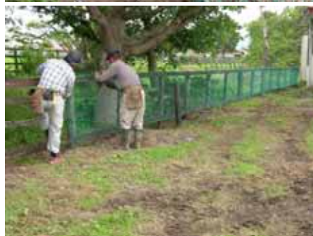
組合員、地域住民等の協力を得て実施した、安全フェンスの直営施工
