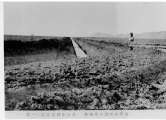
大正時代の排水路新設工事
