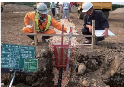
暗渠排水の断面確認
