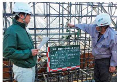
現場打ち枠の配筋検査
