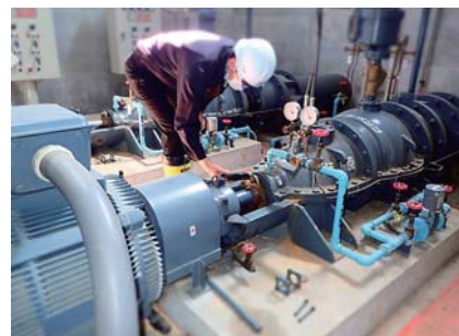
土地改良施設の診断
