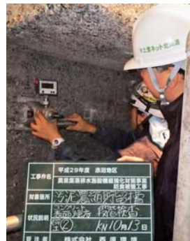
コンクリート表面強度の測定
