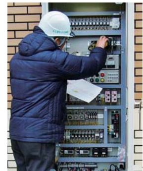
計装機器の配線検査
