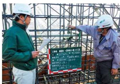
現場打ち枠の配筋検査
