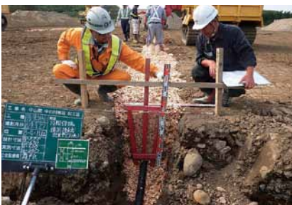
暗渠排水の断面確認
