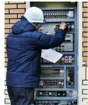
計装機器の配線検査
