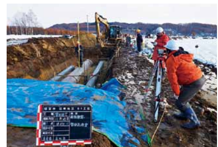
用水路管頂高の測定
