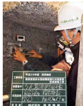
コンクリート表面強度の測定
