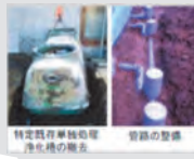
特定既存単独処理 浄化槽の撤去
