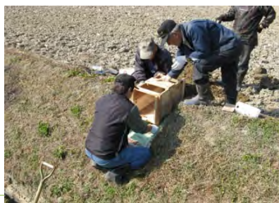
木枠の排水口への設置
