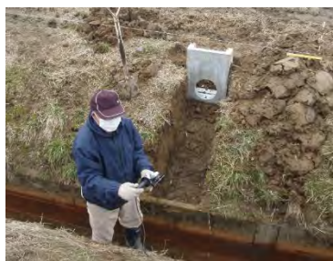
作業状況（水尻柵設置）
