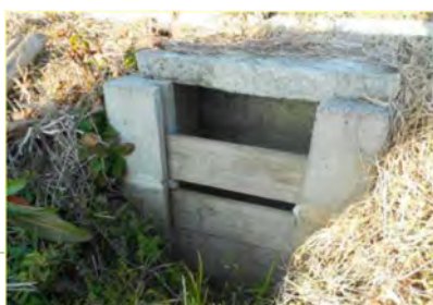
排水口への堰板の設置
