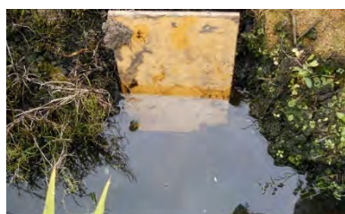
止水板による止水状況
