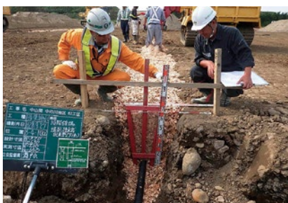
暗渠排水断面確認
