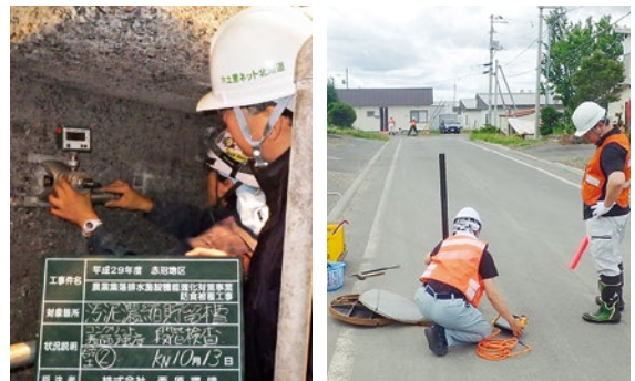
②コンクリート表面強度の測定、管路施設調査
