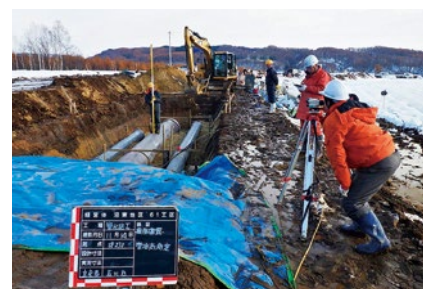
用水路管頂高の測定
