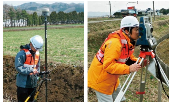
①RTK-GNSS機器やトータルステーションを使用した測量
