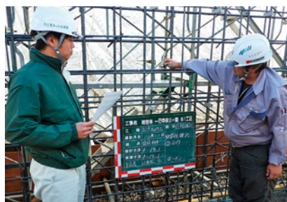
現場打ち枠の配筋検査
